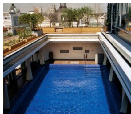
Плитка в плавательном бассейне, уложенная с использованием клея PCI Collastic.
