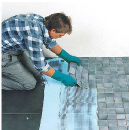
Укладка и выравнивание керамических или каменных плиток на клеевом слое.
